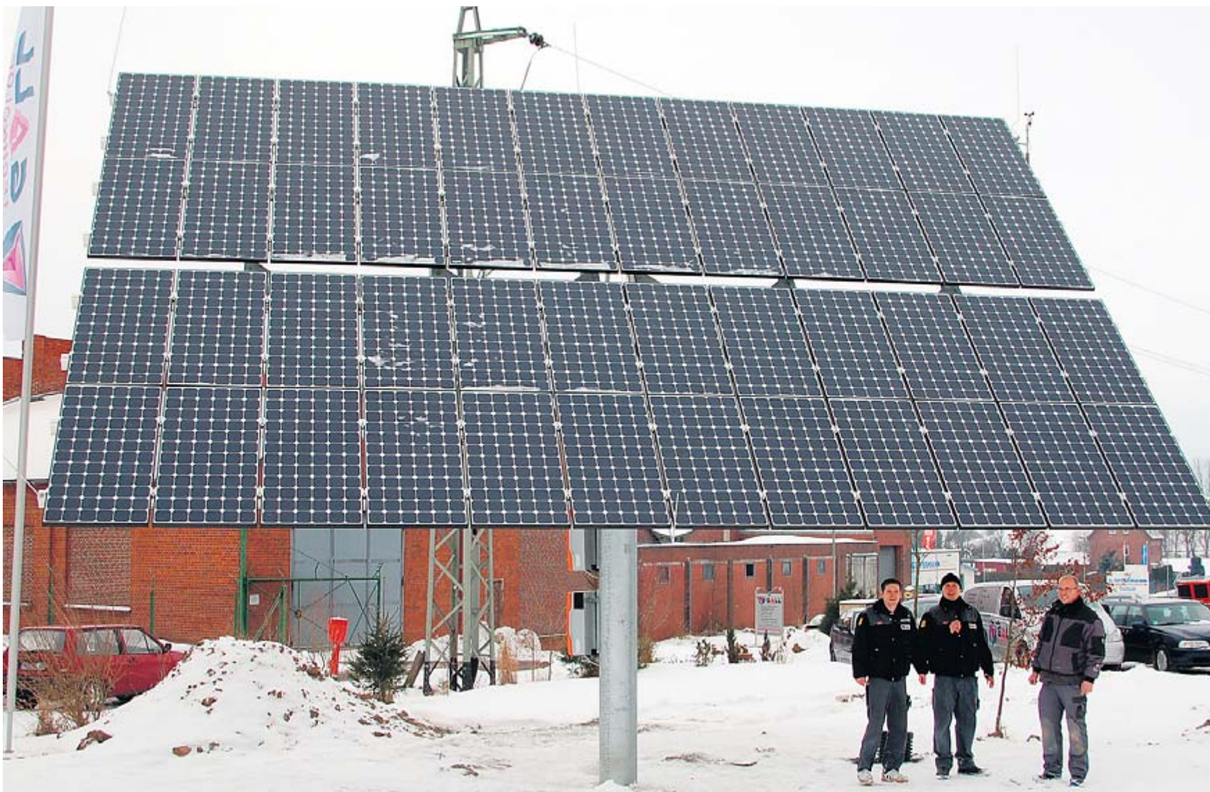
Der „Solar-Tracker“ vor dem Firmengebäude zieht die Blicke auf sich – Gall Technology speist selbst ins Netz, nutzt die Anlage aber auch als Vorführmodell.
