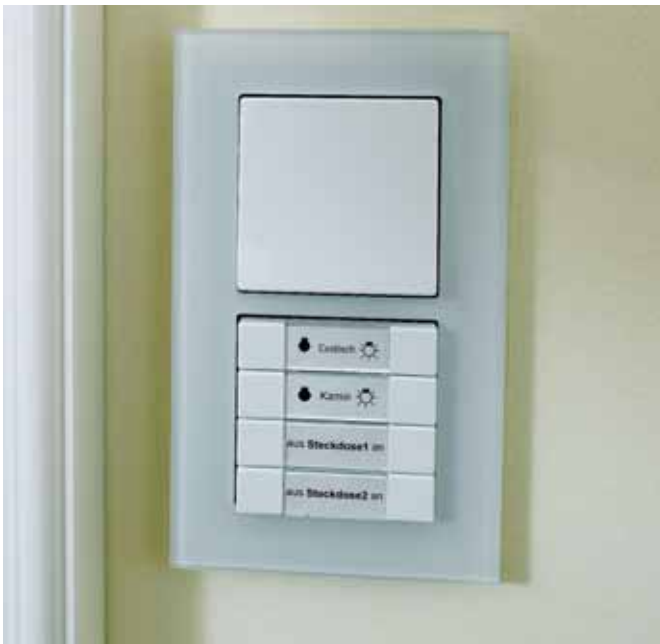
Klassische Schalter in Verbindung mit Mehrfachstastern geben keine Rätsel auf und machen die Funktionsvielfalt bedienbar
